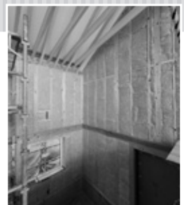
木KEYPlusの断熱施工内部の様子
