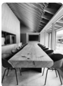
木KEYPlusの内観 (シザーストラス構造を採用)
