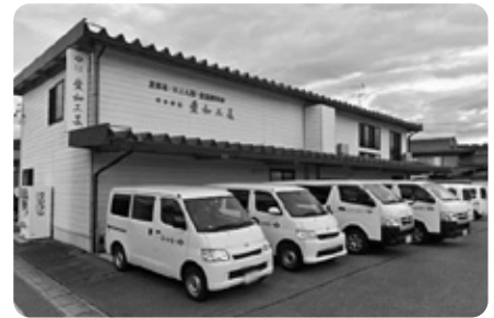
有限会社愛和工芸の外観
