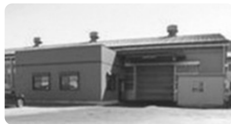
株式会社田口鉄工所の外観
