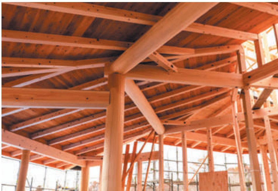
天然乾燥の木材を使用した建設中の建物
