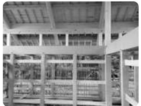
建設中の木造住宅
