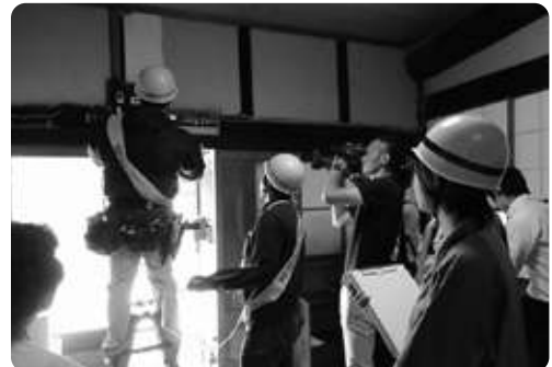
高齢者1人世帯の電気設備点検
