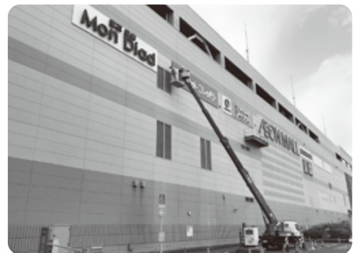
屋外広告の設置現場
